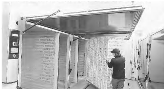
【写真4】滑らず堅牢な床面や、排水溝の工夫で取り出し作業もより安全に
